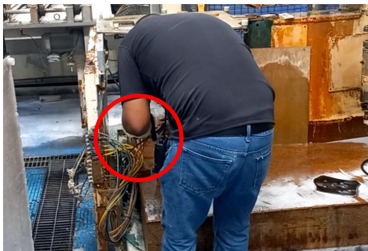
Figura 21: Operador tomando las mangueras neumáticas correspondientes para conexión de guía para taladro (López, 2023).
