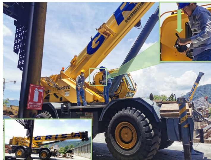
Figura 26 Instalación del inclinómetro en la tornamesa en una grúa con capacidad de 90 toneladas.
