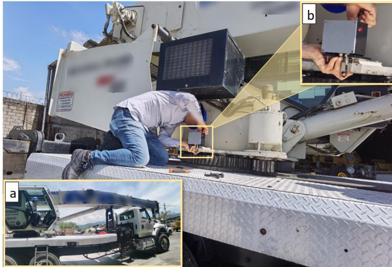
Figura 25 Instalación del inclinómetro en la tornamesa de en una grúa con capacidad de 45 toneladas, a) fotografía de la grúa, b) detalle del sensor.
