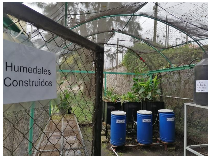
Figura 4.76 Sistema Híbrido de Tratamiento con HCP reubicado
