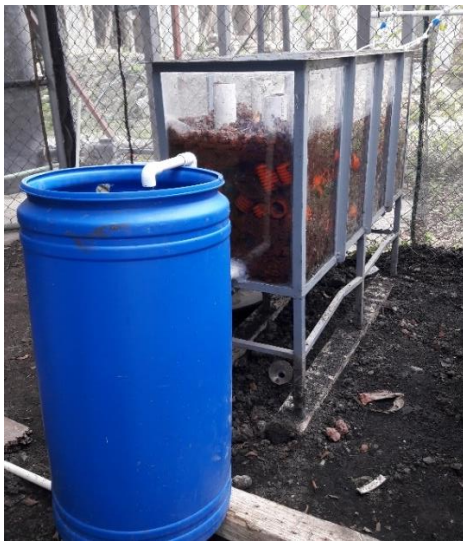
Figura 4.19 Colector de efluente final
