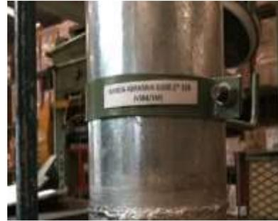
Figura 3. 44 Acciones en la línea: gancho para bandas.
