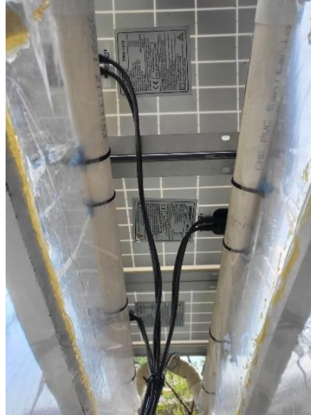
Figura 31 Conexión entre paneles solares ( Elaboración propia )
