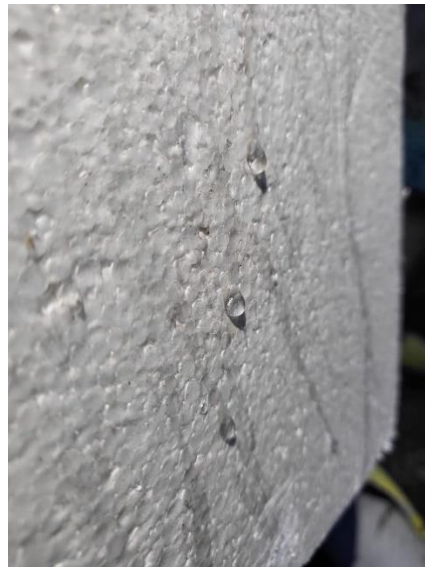
Figura 23 Acumulación de gotas de agua en el prototipo ( Elaboración propia )
