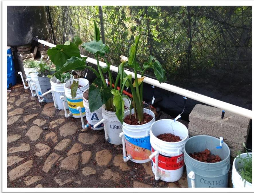
Se instaló tubo de PVC de manera horizontal en el humedal.
