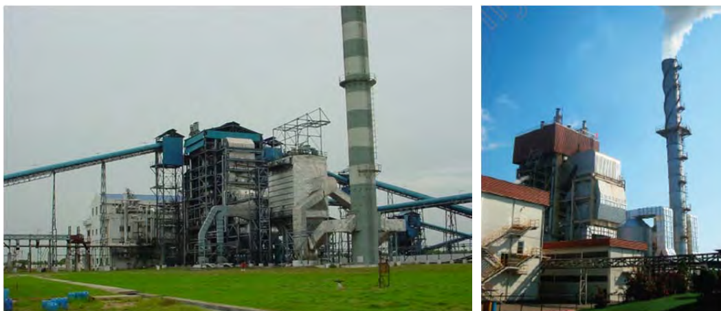
Imagen 54. Plantas de Cogeneración con biomasa de caña
