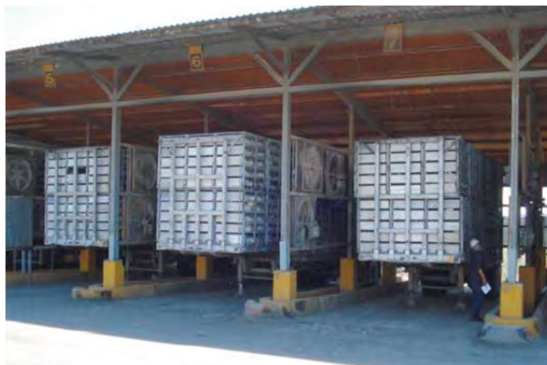
Imagen 6. Andenes de descarga de pollo de engorde
