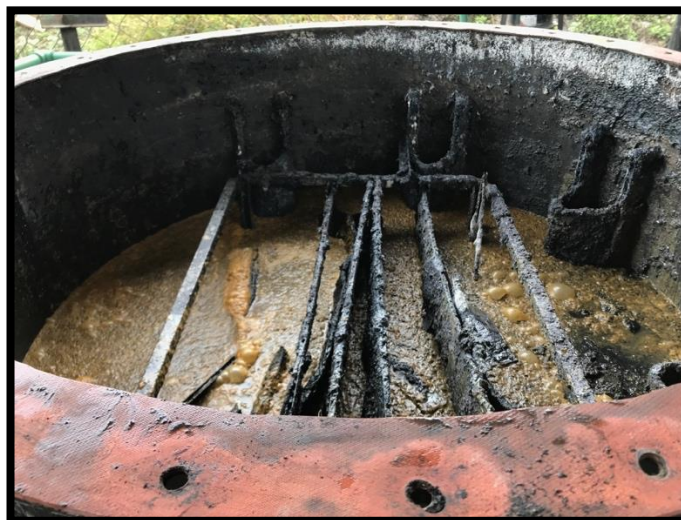
Figura 3.21 Inspección y acondicionamiento del RABF
