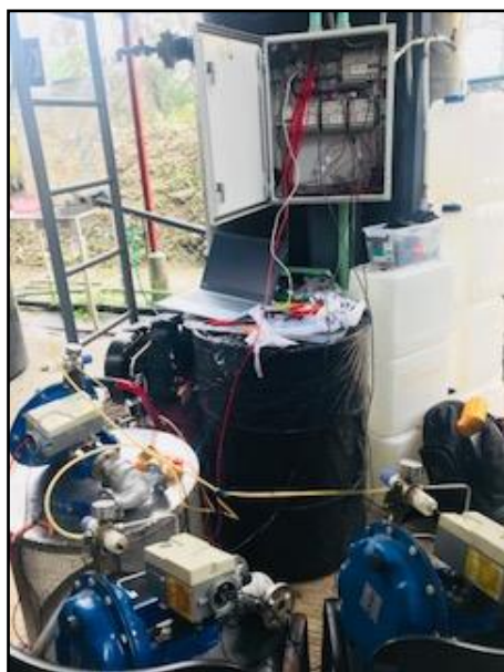
Figura 3.17 Mantenimiento preventivo y correctivo a equipos auxiliares de RLFIAP
