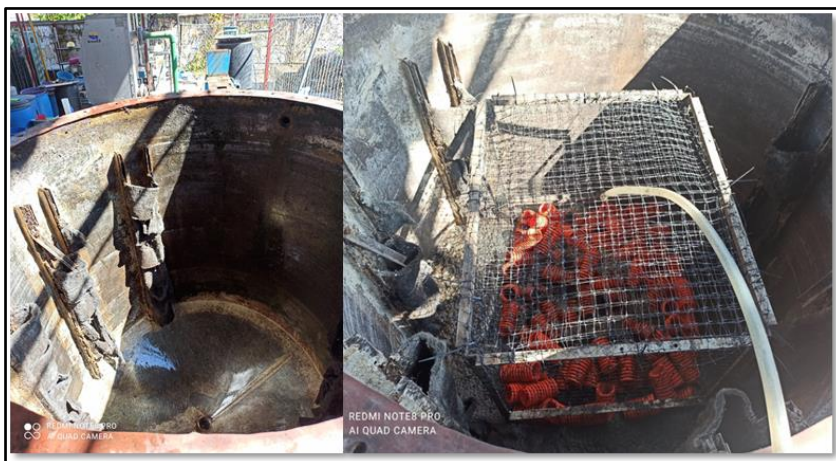
Figura 3.23 Mantenimiento del RABF e implementación de lecho fijo combinado
