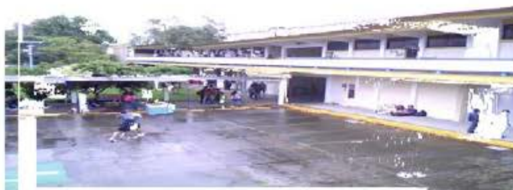
Figura 6. Vista frontal de la explanada
