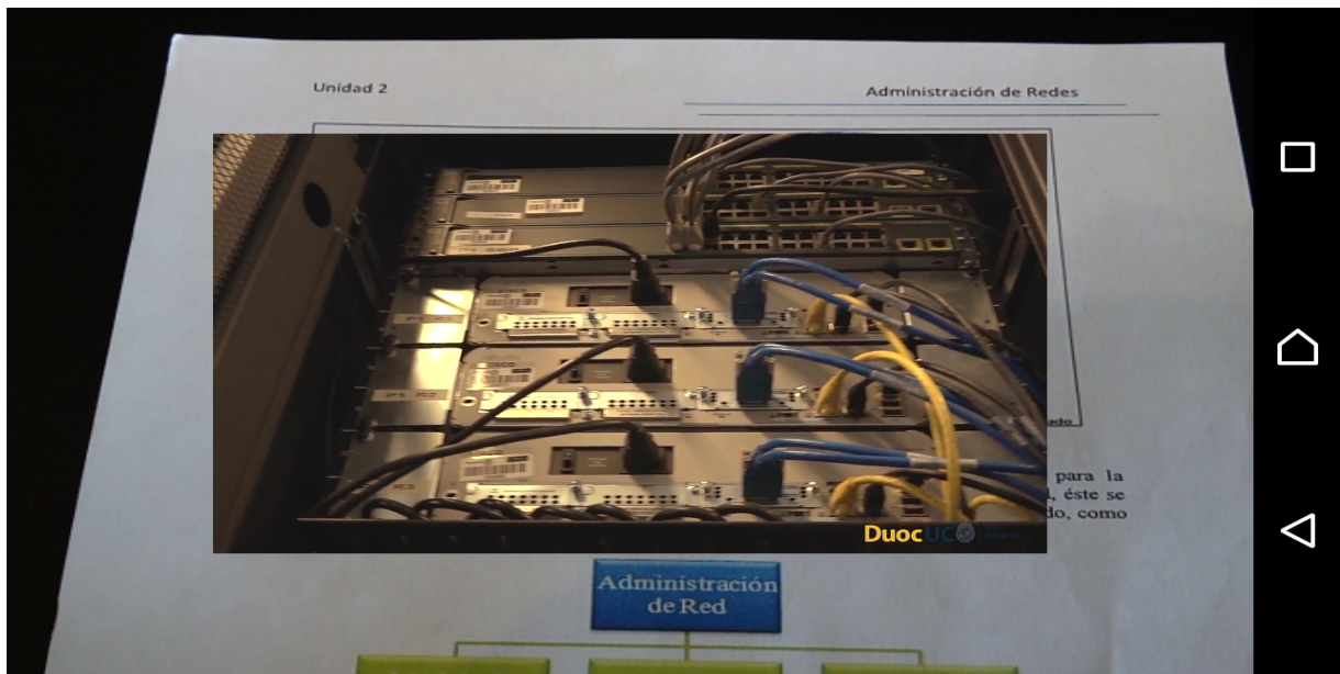
Figura 4. 15 Detección de un marcador y presentación de un video como contenido de RA.
