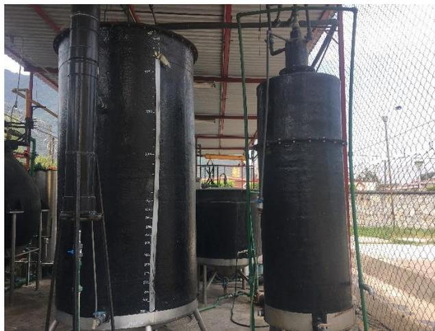
Figura 2.5 Reactores para la D.A en dos fases.
