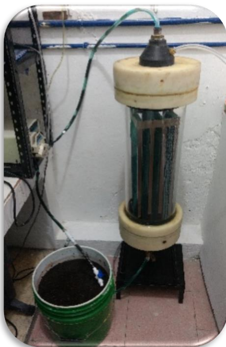
Figura 2.2 Reactor de Hidrólisis Anaerobio (RHA).
