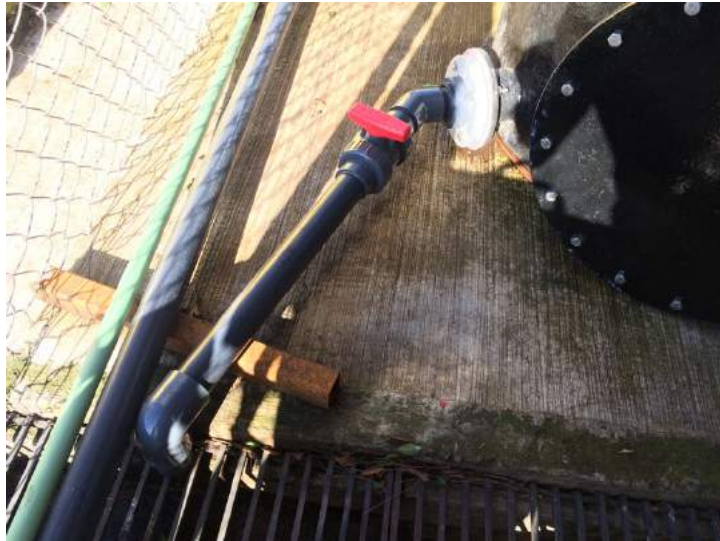
Figura 3.18 Instalación de la tubería para purga de lodos
