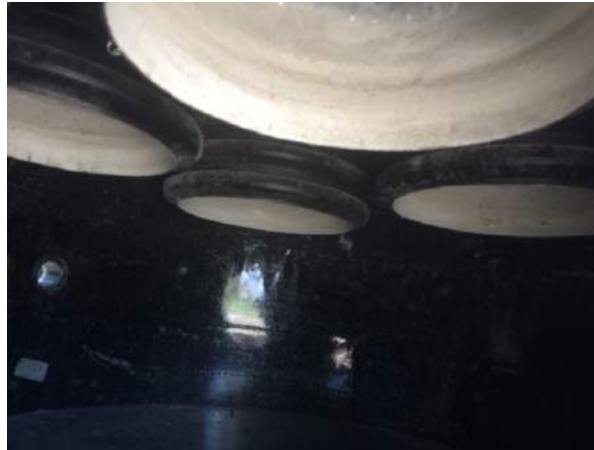
Figura 2.9 Vista inferior de los reactores internos
