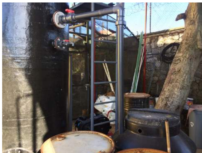
Figura 3.17 Instalación de línea de salida de sustrato
