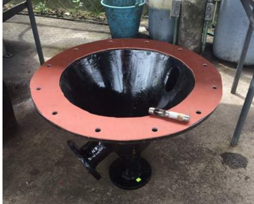
Figura 3.11 Colocación de neopreno a las bridas
