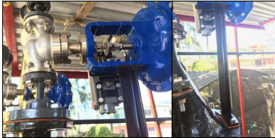
Figura 3.16 Colocación de válvulas de control proporcional
