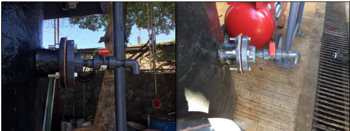
Figura 3.19 Instalación de válvulas para muestreo superior e inferior
