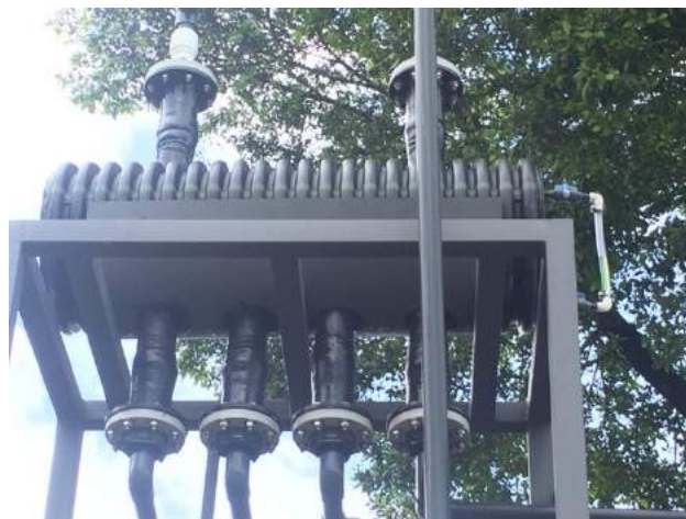
Figura 3.7 Tanque de distribución instalado
