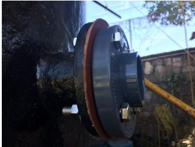
Figura 3.15 Colocación de tapas de bridas
