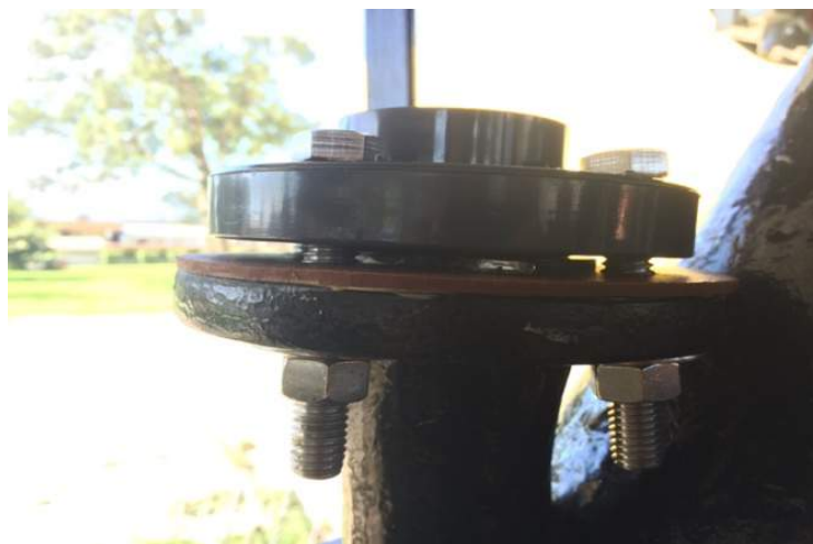
Figura 3.27 Instalación de juntas en entrada de sensores
