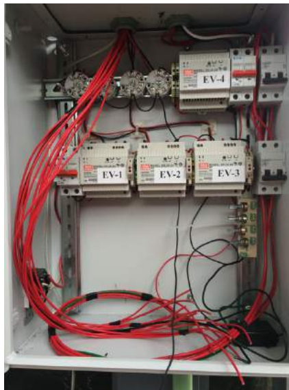
Figura 3.25 Instalación de tablero para sistema electrónico
