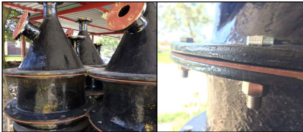
Figura 3.14 Unión de elementos principales del RLFiAP
