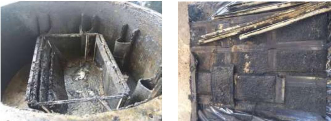
Figura 3. 1 Interior del reactor hidrolítico en mal estado
