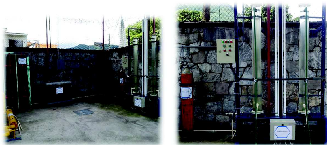
Figura 3. 27 Pruebas hidráulicas en fotobiorreactores
