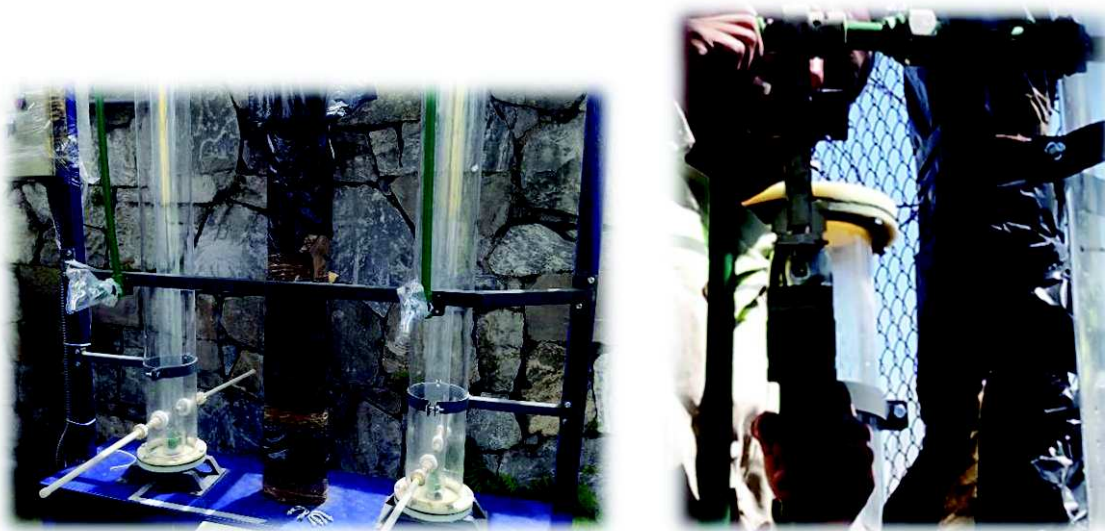
Figura 3. 25 Instalación de tuberías y soporte para recirculación
