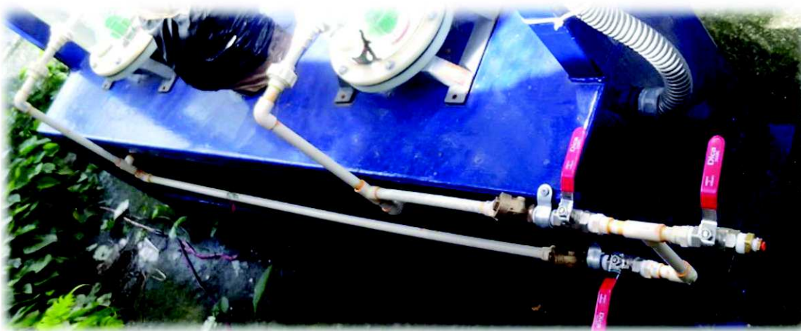
Figura 3. 26 Instalación de tuberías para suministro de CO 2 .
